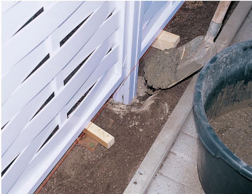
Pfosten direkt ins Erdreich einbetonieren...
