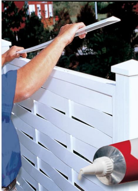
Kleber (0783) zur Befestigung der Aufsatzleisten und Kappen.
