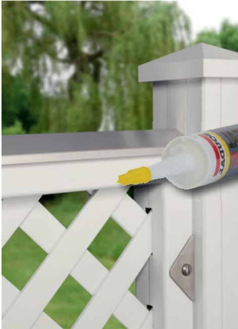
Designaufsatz Alu mit MS-Polymer-Kleber (1398) befestigen.
