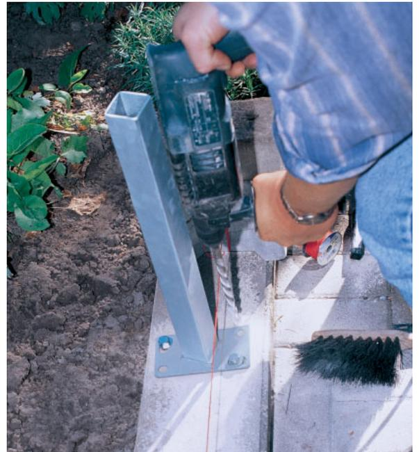
oder mit Pfostenträger aufschrauben.
